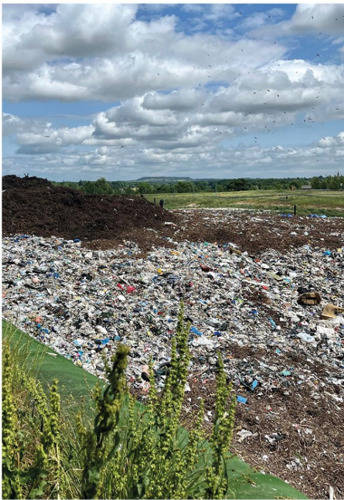
Site d'enfouissement à Monflanquin.
